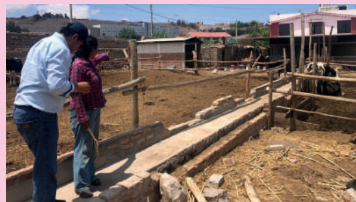
Asesoría en elaboración de diseño para construcción de establo proveedor Vizcarra - zona Moquegua , a cargo del asesor técnico de campo Javier Valverde.
