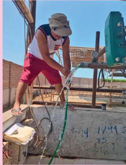
Lavado de tuberías y desarmando de uniones, colectores, etc. Establo La Tablada, a cargo del asesor técnico de campo Edwar Bustamante.
