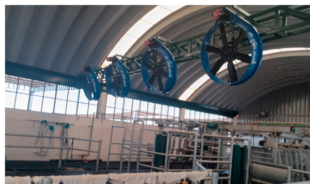
Instalación de ventiladores Delaval al proveedor Paredes Estrada, asesor de campo José Luna.
